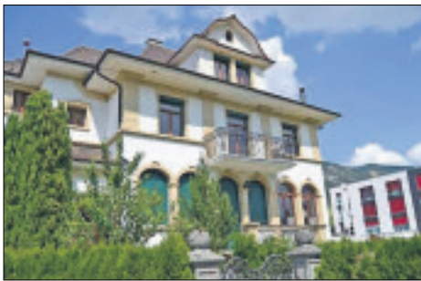
La villa qui accueillera la crèche des Marmottes dès le 1 er novembre à Crémines.
