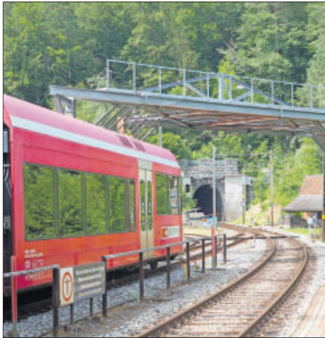
Outre l'assainissement du tunnel (85 millions), des travaux de modernisation du tronçon Moutier-Soleure (notamment des gares) seront également menés, évalués à 100 millions supplémentaires. ARCHIVES
