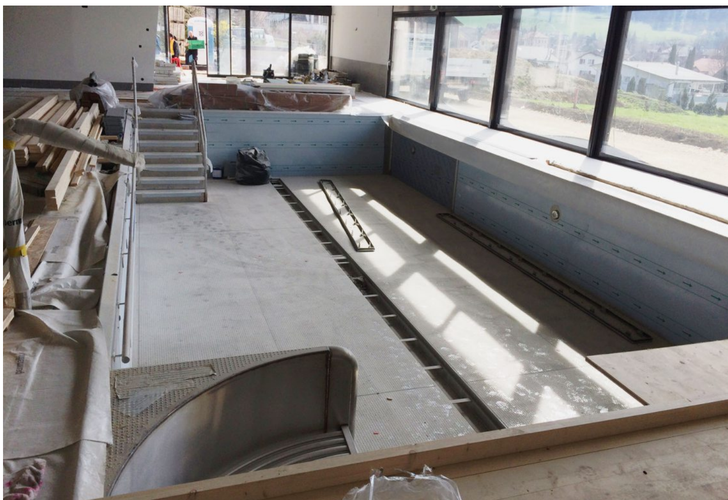
La piscine de l'espace santé et bien-être Aquavirat mesure 12m50 de long pour 6m de large. Dès le début du mois de juin, tout un chacun pourra aller s'y ressourcer. MATTHIEU HOFMANN
